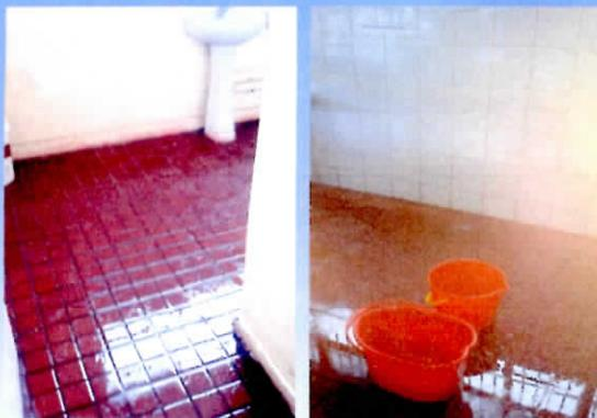
Se observa una filtración prominente en la entrada del baño, lo que generó la inundación del sector.
