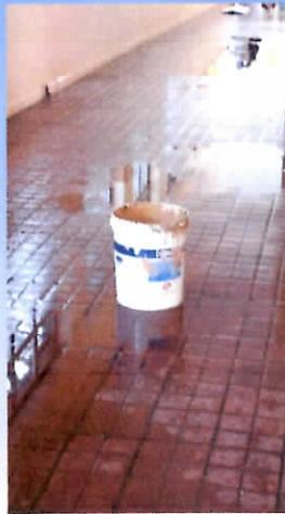
Pasillo completamente inundado, con pintura soplada en muros y vanos de ventanas.
