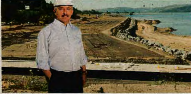
17,14 % de avance llevan las obras de la extensión de la Costanera entre Lonco y S Oriente.
